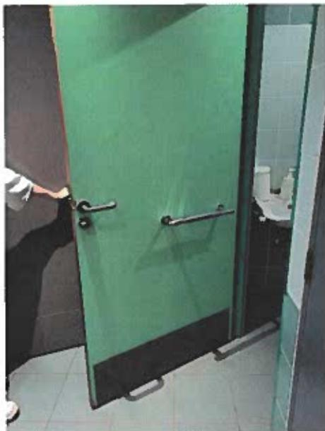
La mise en place de la barre de tirage dans les sanitaires a permis la mise en accessibilité complète du site
