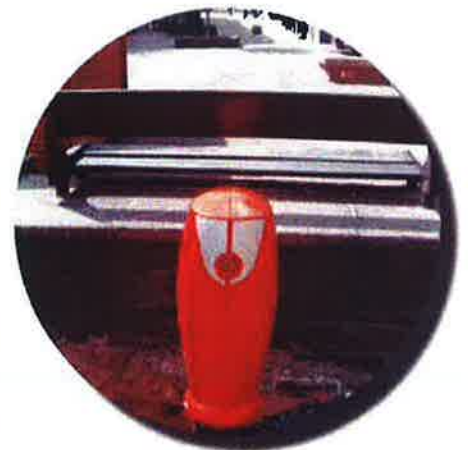
Pose d'un poteau incendie
