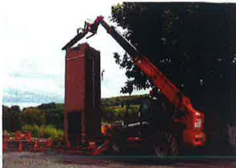
Destruction ancien poste de transformation Dourd'hal
