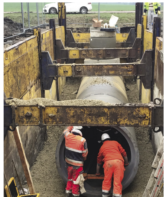
Démarrage des travaux de la Tranche 1 : Mise en conformité de l'assainissement des communes de Diffembach-Les-Hellimer et Hellimer
