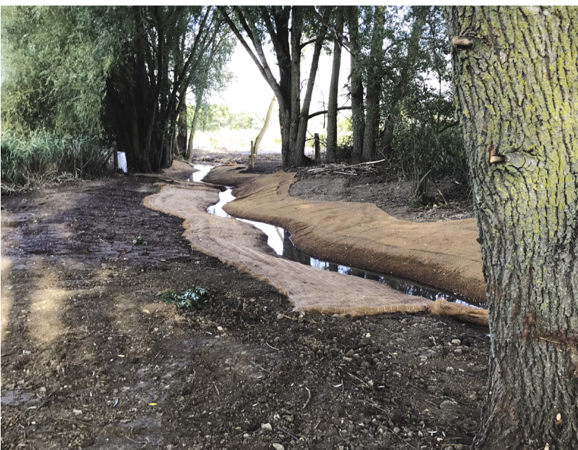
Démarrage des travaux de renaturation des cours d'eau des communes de Gréning et Petit-Tenquin
